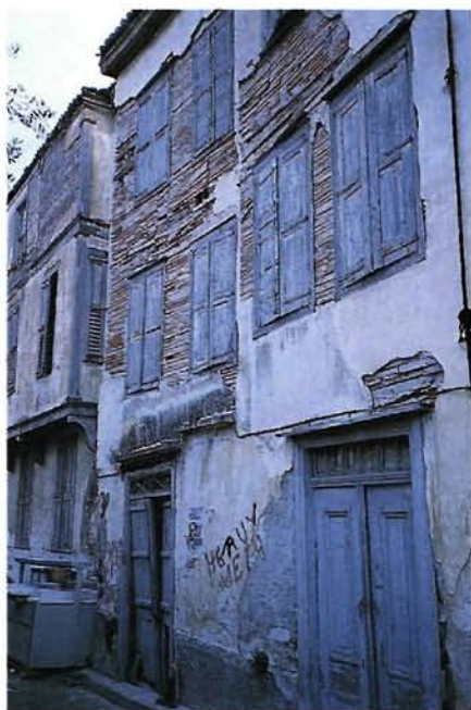
Οικία τύπου Α, στην πόλη της Μυτιλήνης. Τοιχοποιεία από μαργδατί. Γνώρισε ευρεία διάδοση πριν από την πυρκαγιά του 1851.
