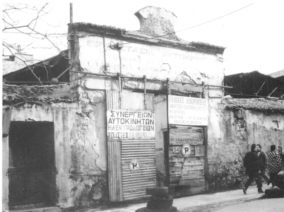
11. “Εργοστάσιον αυτοκινήτων” (σήμερα σταθμός) στην οδό Μυλλέρου 54: ζωντανός μάρτυρας μιας μακρόχρονης, και ξεχασμένης, ιστορίας.
