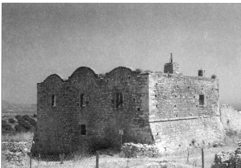
Η ΝΑ άποψη του διώροφου κτιρίου με τις αντηρίδες.
