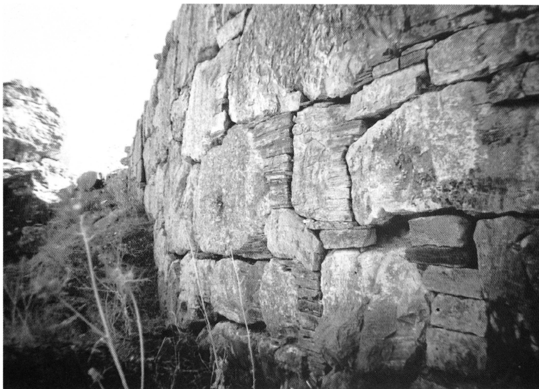
Εικ. 22. Η δομή του Α. τείχους του ανδῆρου στον ναό της Αθηνάς.
