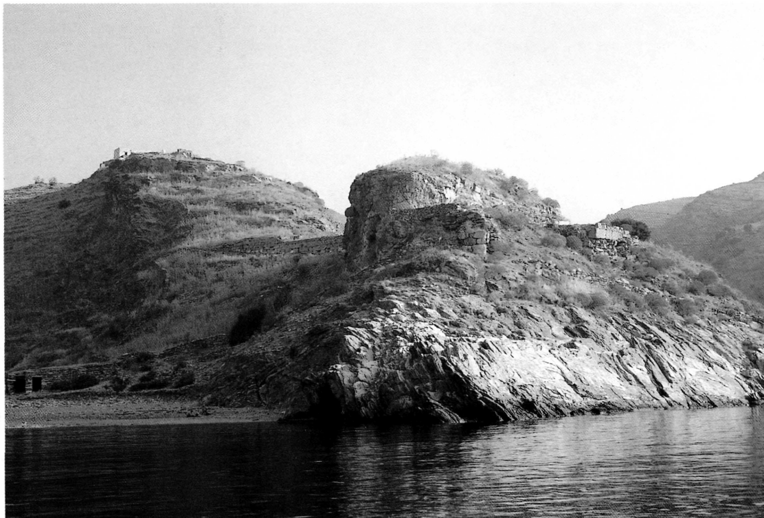
Εικ. 1. Γενική άποψη της Ν. κλιτύς της Ακροπόλεως. (Φωτ. Α.Γ. Μενδώνη).
