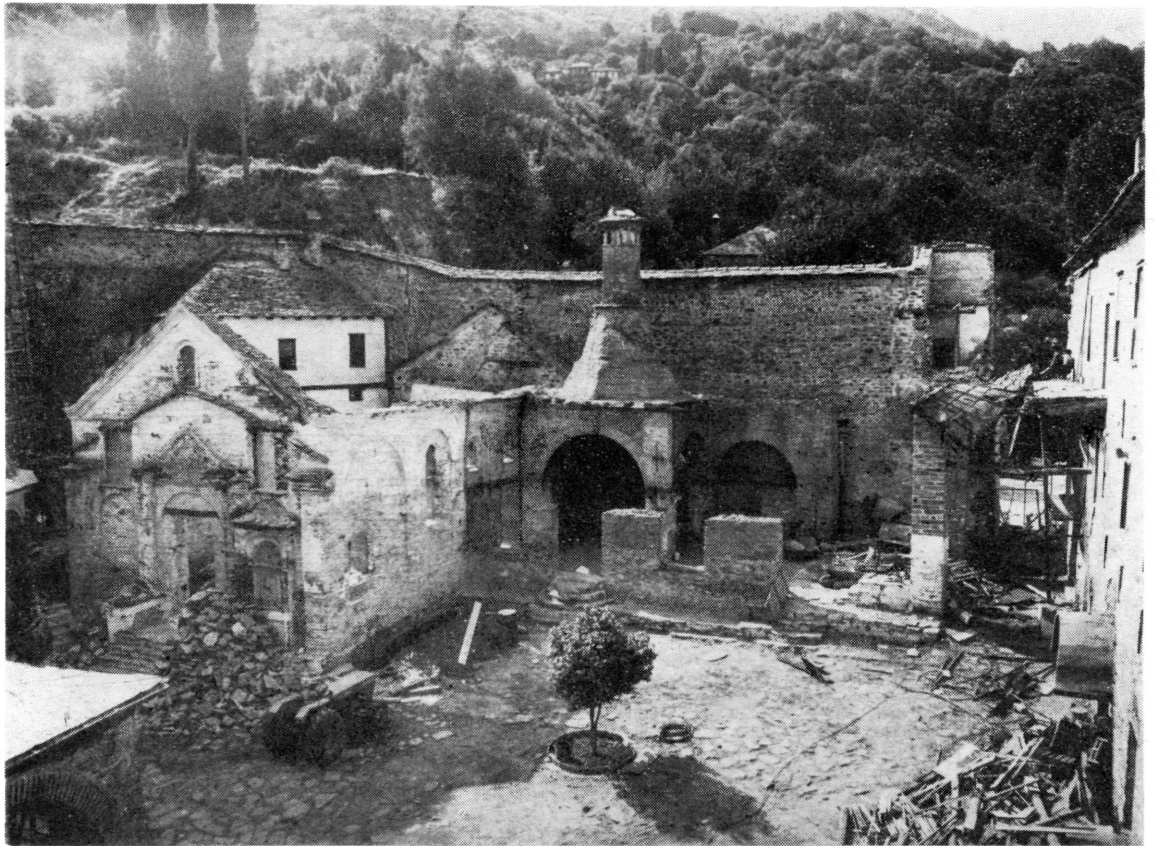
Εικ. 5. Μ. Κουτλουμουσίου, τράπεζα και μαγειρείο. Κατεδάφιση όλων των ξύλινων και ξυλόπηχτων μερών τους.
