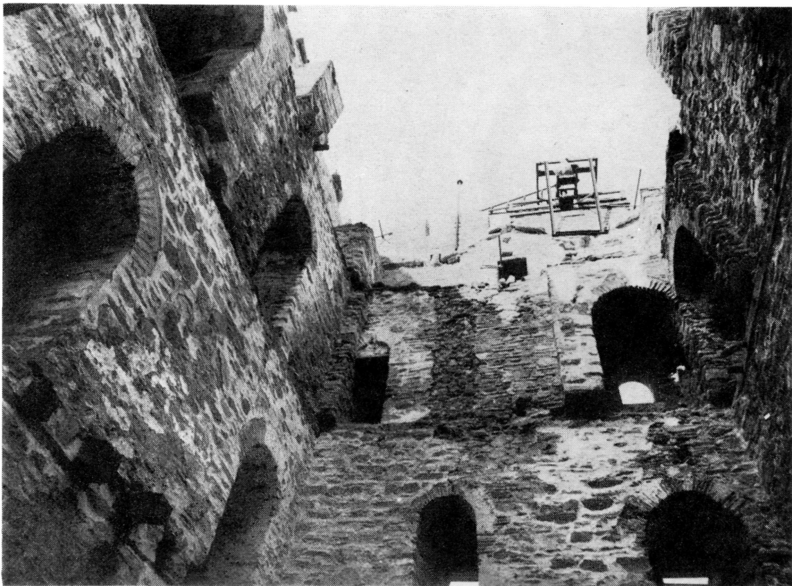
Εικ. 8. Μ. Παντοκράτορος, εσωτερικό του πύργου μετά τις κατεδαφίσεις.
