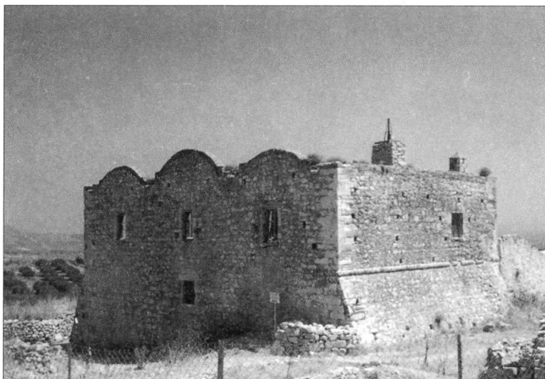
Η ΝΔ άποψη του διώροφου κτιρίου με τις αντηρίδες.
