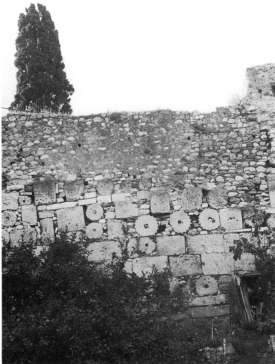
3. Τμήμα του τείχους της βόρειας πλευράς.
