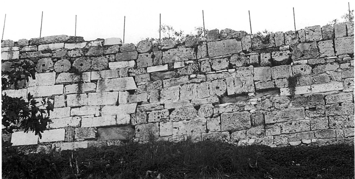
2. Τμήμα του τείχους της βόρειας πλευράς.
