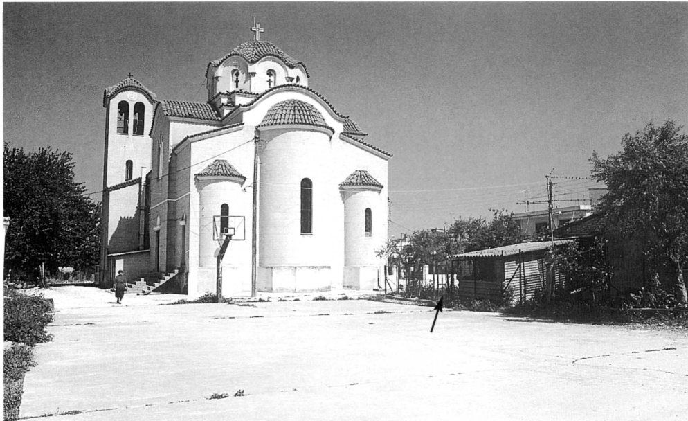
12. Ἀποψη τοῦ ναοῦ τῶν Ταξιαρχῶν Παλαιᾶς Μανολάδας, ΒΔ του ὁποῖου ἐντοπίζονται τὰ κατάλοιπα τῆς λουτρικῆς ἐγκατάστασης.
