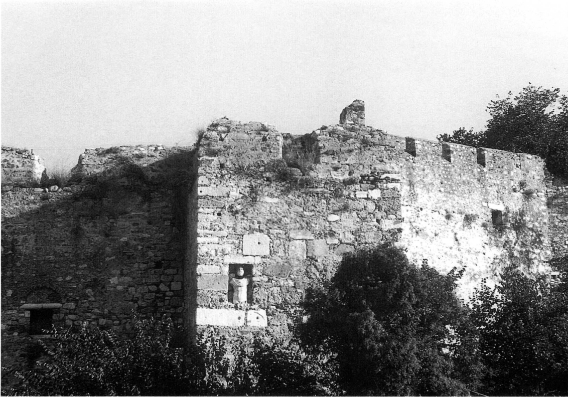
6. Ο νότιος πύργος «της Πατρινέλας». Στη νότια όψη διατηρούνται σε ύψος τμήματα της α' οικοδομικής φάσης.
