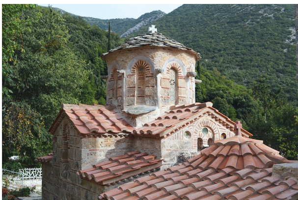
Εικ. 6α: Άγ. Πέτρος Καστάνιας, νότια όψη.
