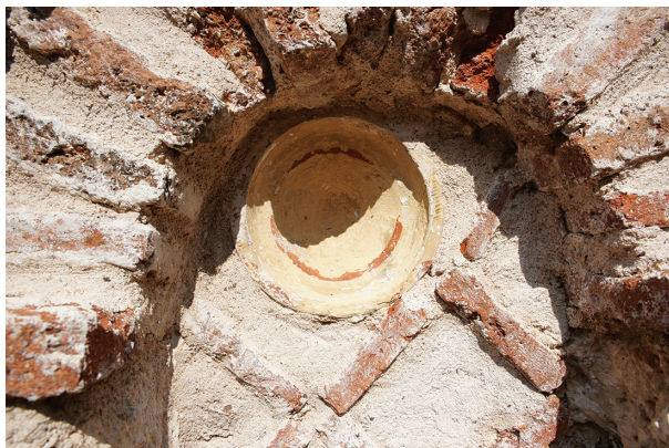
Εικ. 24: Κοίμηση Θεοτόκου Καστάνιας. Εντοιχισμένο αγγείο νοτιοανατολικής πλευράς τρούλλου («RMR Ware»).
