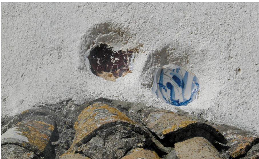
Εικ. 28: Καλύβια. Μεταμόρφωση του Σωτήρος, Α. όψη. Εντοιχισμένα αγγεία (Φωτ. Α. Γ. Γιαγκάκη).
