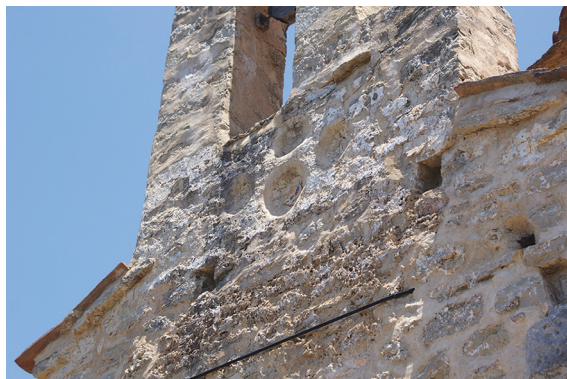
Εικ. 67: Καθολικό Μονής Αγ. Παρασκευής Κάτω Δολών. Οι υποδοχές των αγγείων στη δυτική όψη του ναού.
