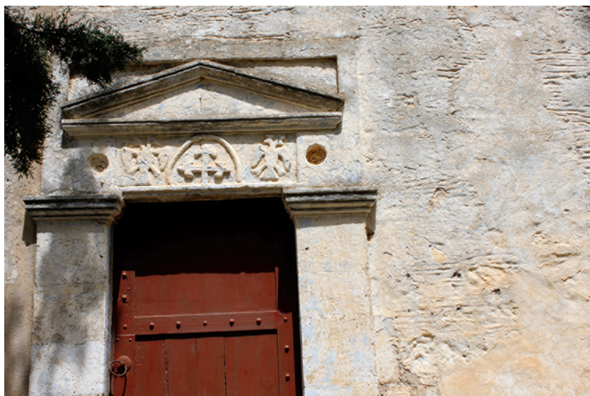
Εικ. 24: Αίγινα. Παλιαχώρα. Άγιος Διονύσιος-Παναγία (Επισκοπή). Υποδοχές για τον εντοιχισμό δύο αγγείων στις άκρες του πώρινου υπερθύρου, δυτικά (φωτ. ΕΦΑ Πειραιώς και Νήσων, Υπουργείο Πολιτισμού).
