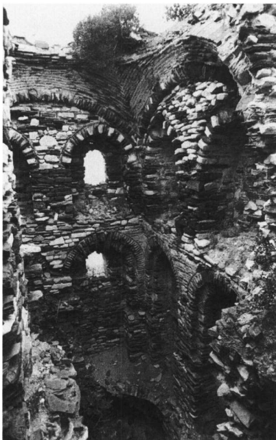
6. Εσωτερική άποψη προς τα βορειοανατολικά
