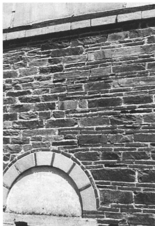
21. Παρεκκλήσι Αγίου Νικολάου. Δύο διαφορετικές κατασκευαστικές φάσεις στη δυτική όψη
