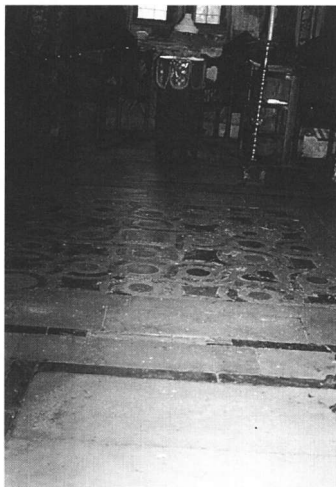
23. Η σχέση του διακοσμητικού δαπέδου του κυρίως ναού με τον εγκάρσιο άξονα στο ύψος των χορών
