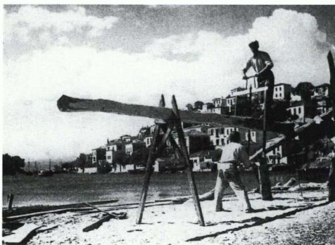
Εικ. 17 Το πριόνι με πλαίσιο της ναυπηγικής σε λειτουργία. Φωτογραφία από τη Σάμο, (ΥΠΠΟ - ΕΙΕ, Ναυπηγική και πλοία της Ανατολικής Μεσογείου και Μαύρης Θάλασσας κατά τον 18ο και 19ο αιώνα , Αθήνα 1995, 58)
