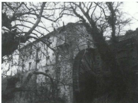
Εικ. 14 Ο νερόμυλος του Εμπειρίκου στην Ανδρο, με τη σιδερένια κατακόρυφη πτερωτή, που λειτουργούσε εναλλακτικά και με ατμομηχανή τοποθετημένη στο παρακείμενο κτίσμα (Χ. Αγγιαντώνη, Ο ατμόμυλος του Εμπειρίκου στην Ανδρο, Τεχνολογία 3, 1989, 22)
