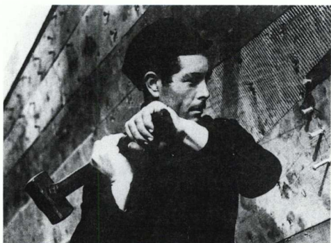
Εικ. 18 Κάρφωμα πετώματος με το σφυρί (ΥΠΠΟ - ΕΙΕ, Ναυπηγική και πλοία της Ανατολικής Μεσογείου και Μαύρης Θάλασσας κατά τον 18ο και 19ο αιώνα , Αθήνα 1995, 71)
