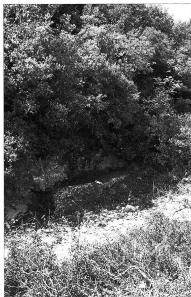
36. Λάκκος Τσιφλικιοῦ Πλατανοτόπου: λιθόπλινθοι ἀπὸ τό ποδαρικό τῆς ὕδατογέφυρας [φωτ. Γ. Α. Π.: 17.7.92]
