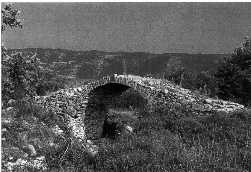
34. Μεσορόπη: τῆς Μαχμούδας ἡ Γεφύρα [φωτ. Γ. Α. Π.: 15.7.92]
