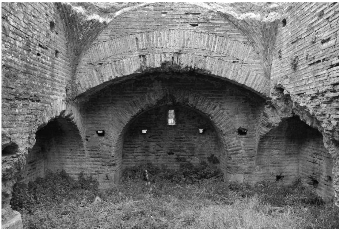
Fig. 14. Interno del mausoleo RG 5 verso NO con gli arcosoli disposti lungo le pareti e i resti della volta a vela.
