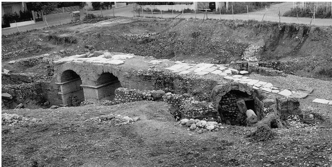
Fig. 12. Pont romain, à proximité de Patras, sur la route antique qui conduisait à Aigion.
