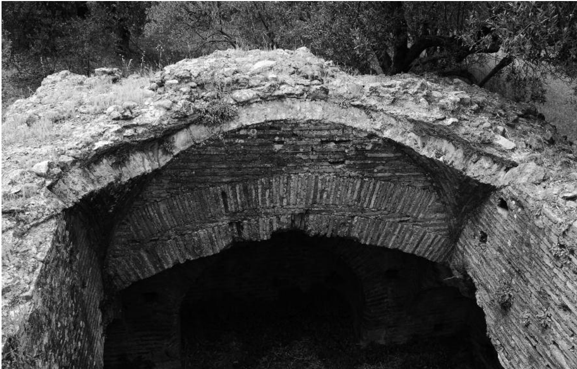
Fig. 16. Particolare della volta a vela realizzata con la tecnica dei mattoni affiancati che si intersecano lungo le diagonali.
