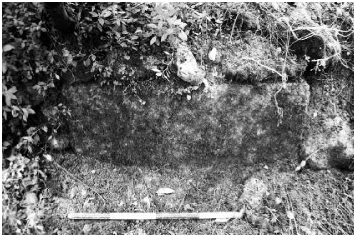
Fig. 31 - Particolare del blocco in conglomerato inserito nel muro di terrazzamento (UT78003)
