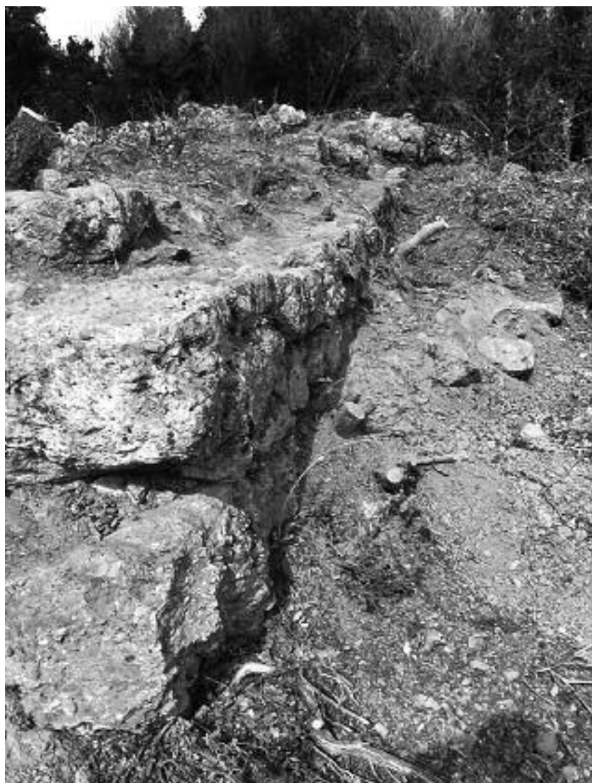
Fig. 3 - UT65001: particolare della struttura in blocchi di conglomerato
