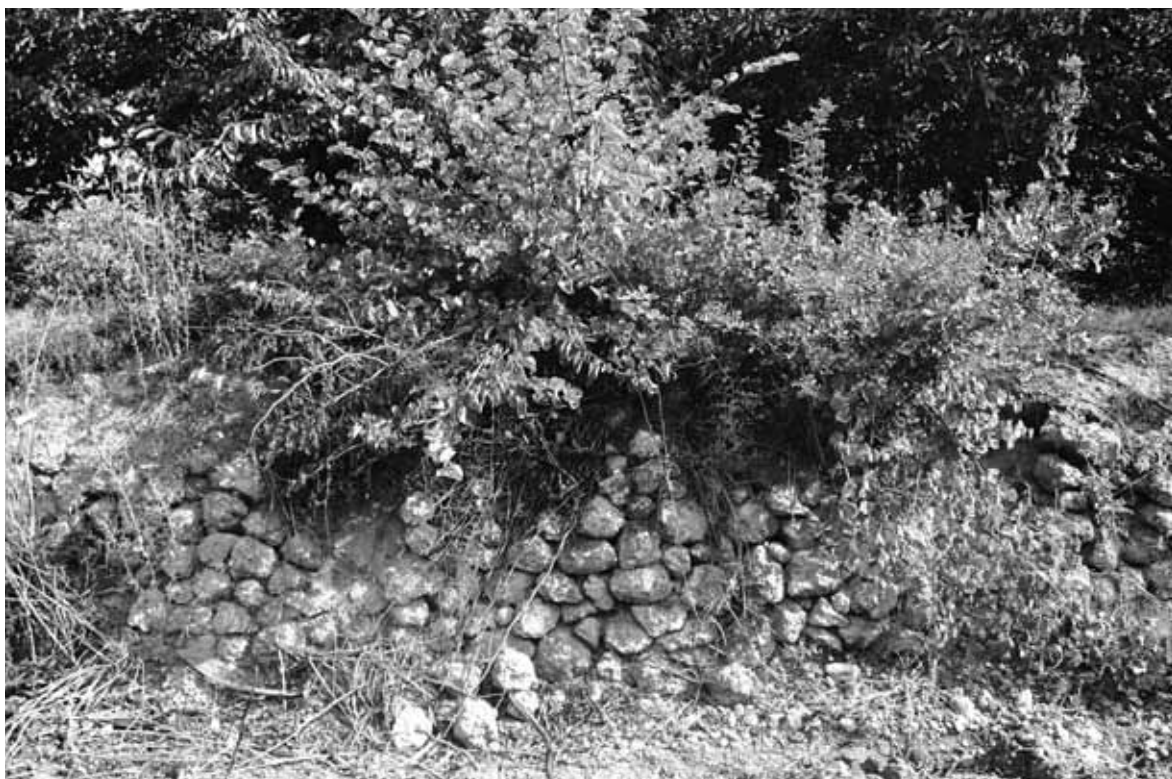
Fig. 12 - Budussa. Sito 65. Muro di terrazzamento visto da SW
