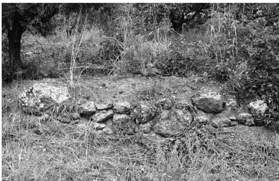
Fig. 7 - Oasi. Probabile sito 64. Muro di terrazzamento visto da S
