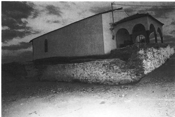
Εικ. 10. Επισκοπή Ωλένης. Άποψη από βορειοδυτικά
