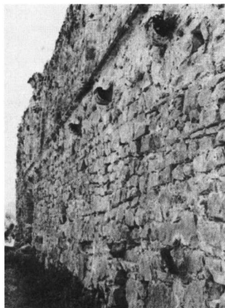
Εικ. 10. Ίσοβα, εκκλησία της Παναγίας. Βόρειος τοίχος με φουρούσια στα οποία ακουμπούσε η σκελασμένη αυλή των μοναχών
