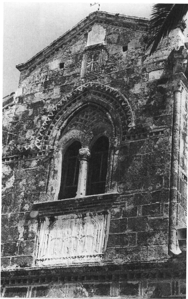
Εικ. 1. Μονή Βλαχερνών. Νότια όψη εσωνάρθηκα (όροφος)
