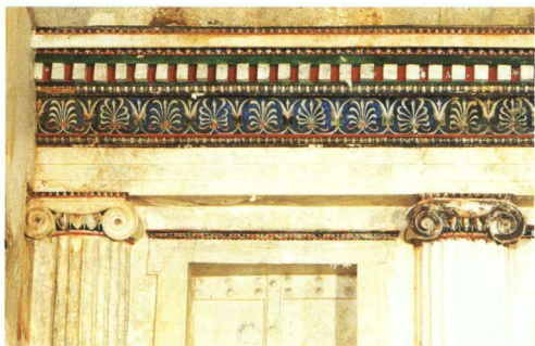
1. Façade intérieure : partie Ouest de l'entablement
