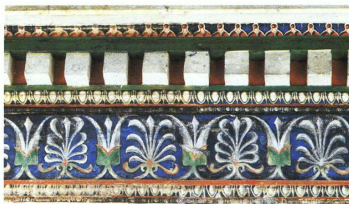
2. Façade intérieure : frise ionique, détail
