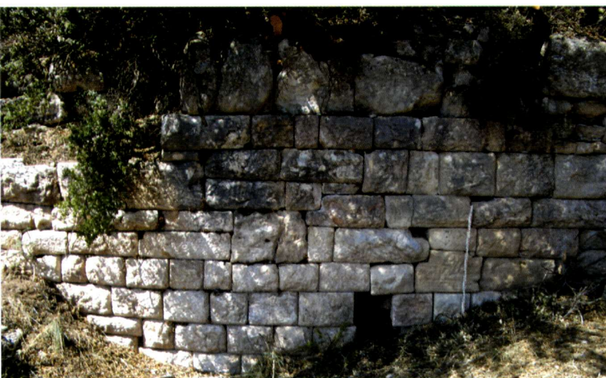
49. Mauerabschnitt der Agora-Stützmauer von Süden. Photo: O. Hüllden
