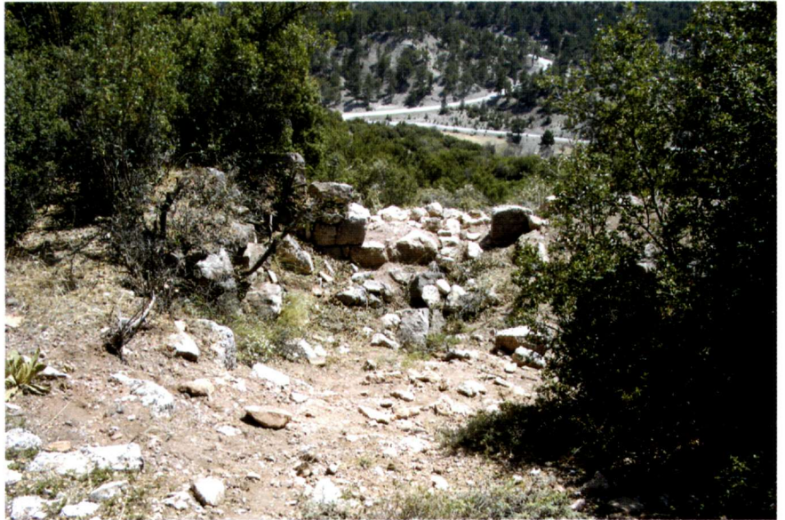
46. Blick von Nordwesten ins Innere des südwestlichen Turms der 'Sperrbefestigung' unterhalb der Akropolis. Photo: O. Hüllden
