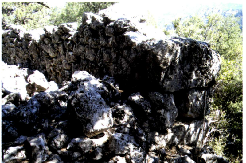
68. Kale Tepe, befestigte Siedlung: östliche Laibung von Tor B. Photo: O. Hüllden
