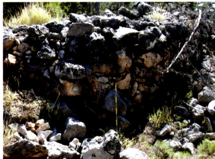
72. Befestigte Anlage bei Divre: Mauerwerk. Photo: M. Stoll
