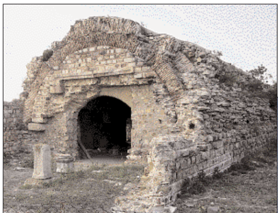
▲ Το εντυπωσιακό καμαροσκεπές κτίριο των πρώιμων οθωμανικών χρόνων γνωστό ως «Χάνα» (φωτ.: Ι. Βιγγοπούλου).
