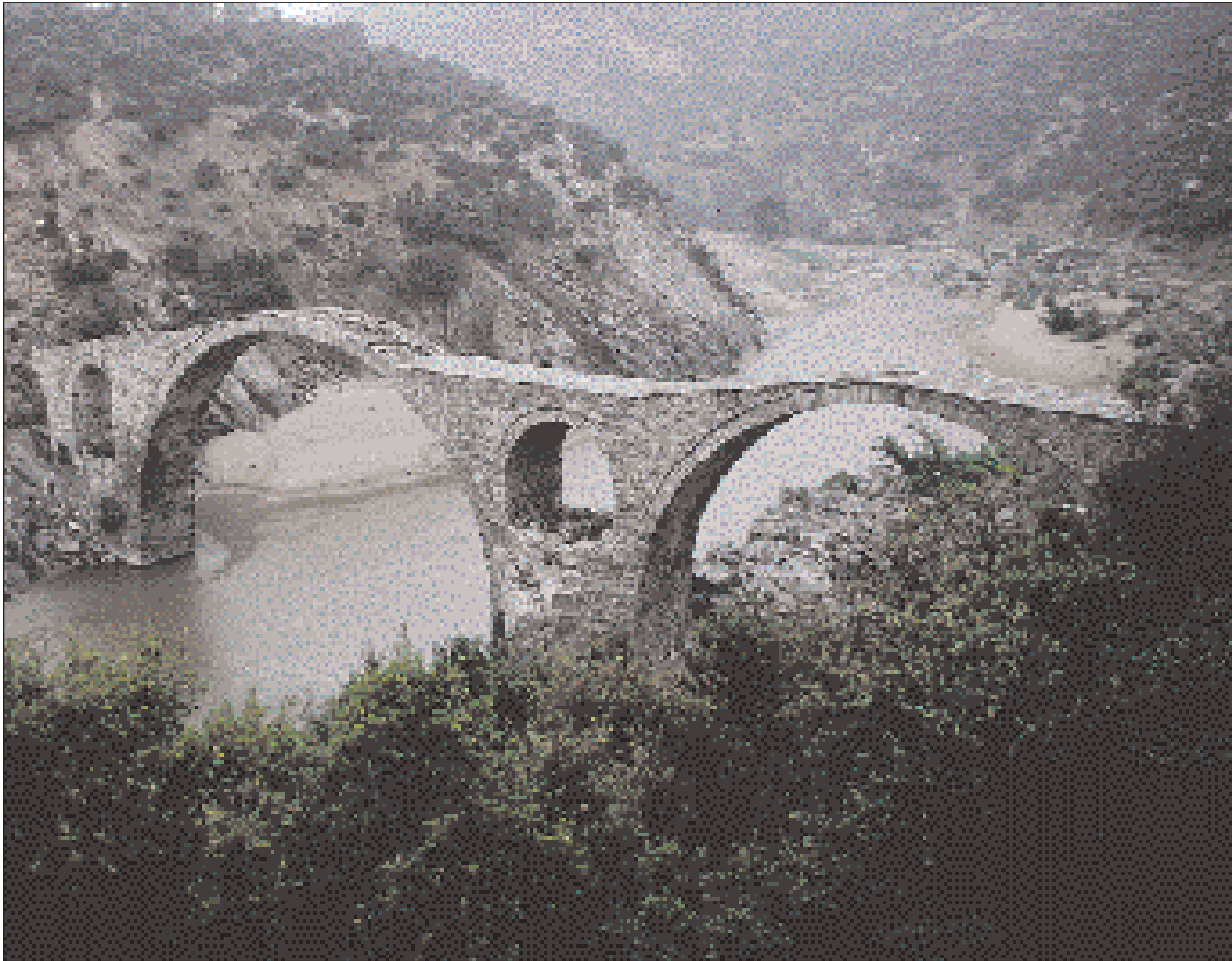
◀ Η τρίτοξη γέφυρα του Κομποτάιου σε χαράδρα του ομώνυμου ποταμού, ο οποίος τροφοδοτεί τη Λίμνη Βιοτονίδα. Το πέτρινο γεφύρι κτίστηκε από Ηπειρώτες μασιόρους τον 18ο αι. (φωτ.: Ι. Βιγγοπούλου).
