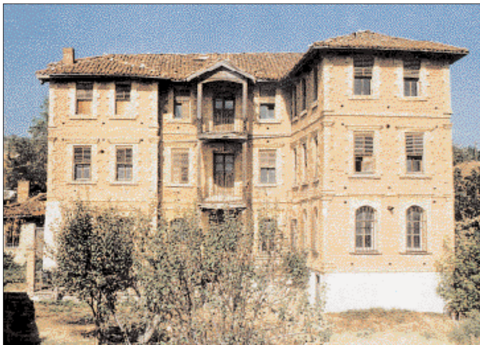
◀ Οικία Μπρίκα στο Σουφλί. Η σηροτροφία έβαλε το στίγμα της στην αρχιτεκτονική του οικισμού και τη λειτουργική οργάνωση της κατοικίας (τα γνωστά κουκουλόσπιτα), η οποία εκτός από χώρο διαμονής λειτουργεί και σαν παραγωγική μονάδα (φωτ.: «Η σηροτροφία στο Σουφλί», εκδ. Πολιτιστικό Τεχνολογικό Ίδρυμα ΕΤΒΑ, 1992).
